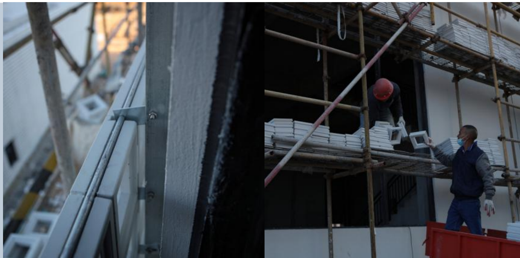
砌砖凹槽设计满足高层结构安装
